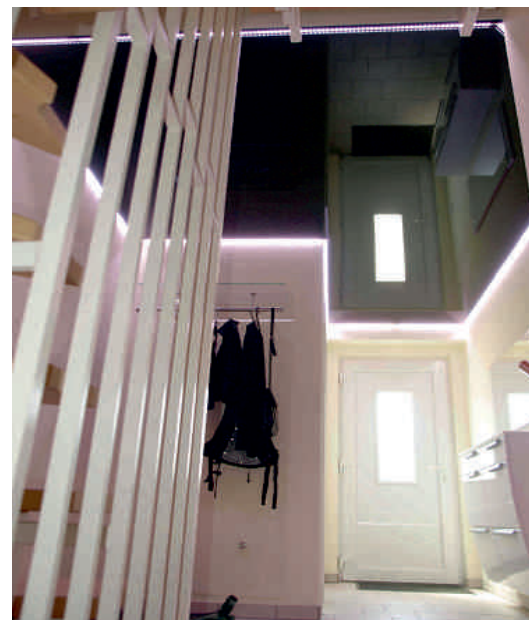
Beispiel Montage von Spanndecken mit LED Beleuchtung
